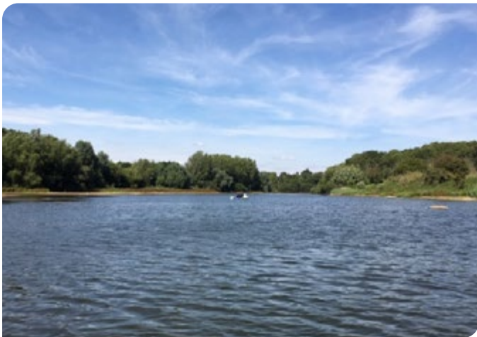
Figura 2: El equipo MPC-Buoy instalado en el embalse Alton de Anglian Water para vigilar y controlar las floraciones de algas.
