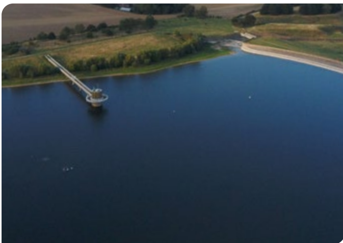
Figura 1: La reserva de agua de Alton de Anglian Water
