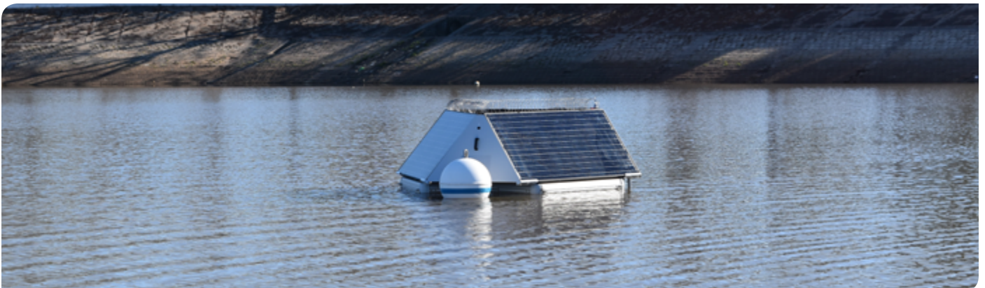
Figura 1: El sistema MPC-Buoy instalado en Puerto Federación
