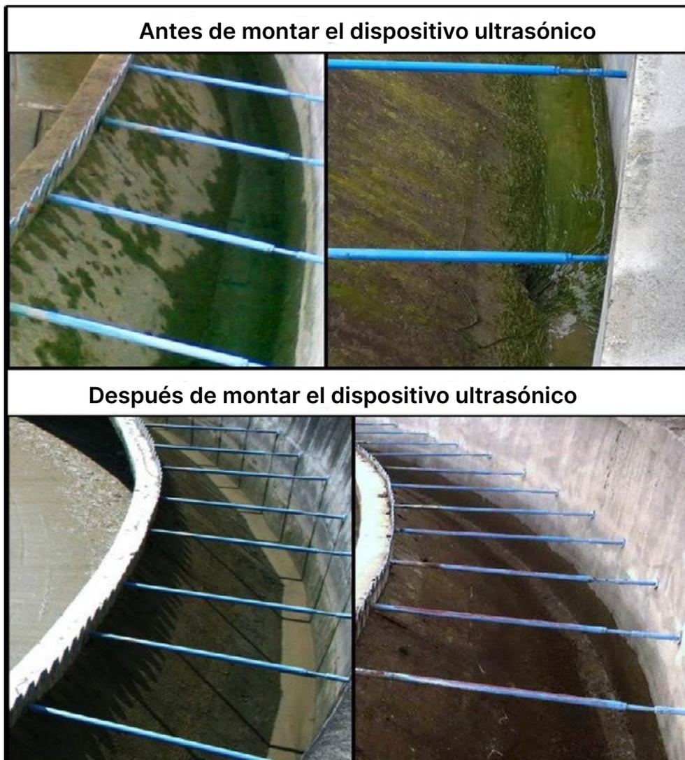
Figura 12- Canales colectores radiales cuando están parados para su lavado y desinfección
